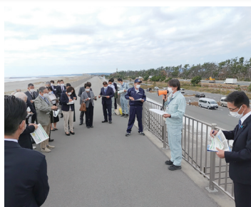
防潮堤破損状況の確認
