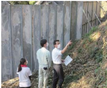
急傾斜地工事状況確認
