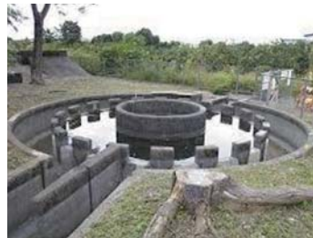
三方原用水の改良工事 末端施設の耐震化対策 老朽化対策。
